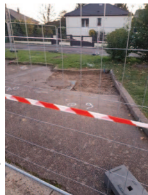
Photo : Affaissement du parking rue de la république
